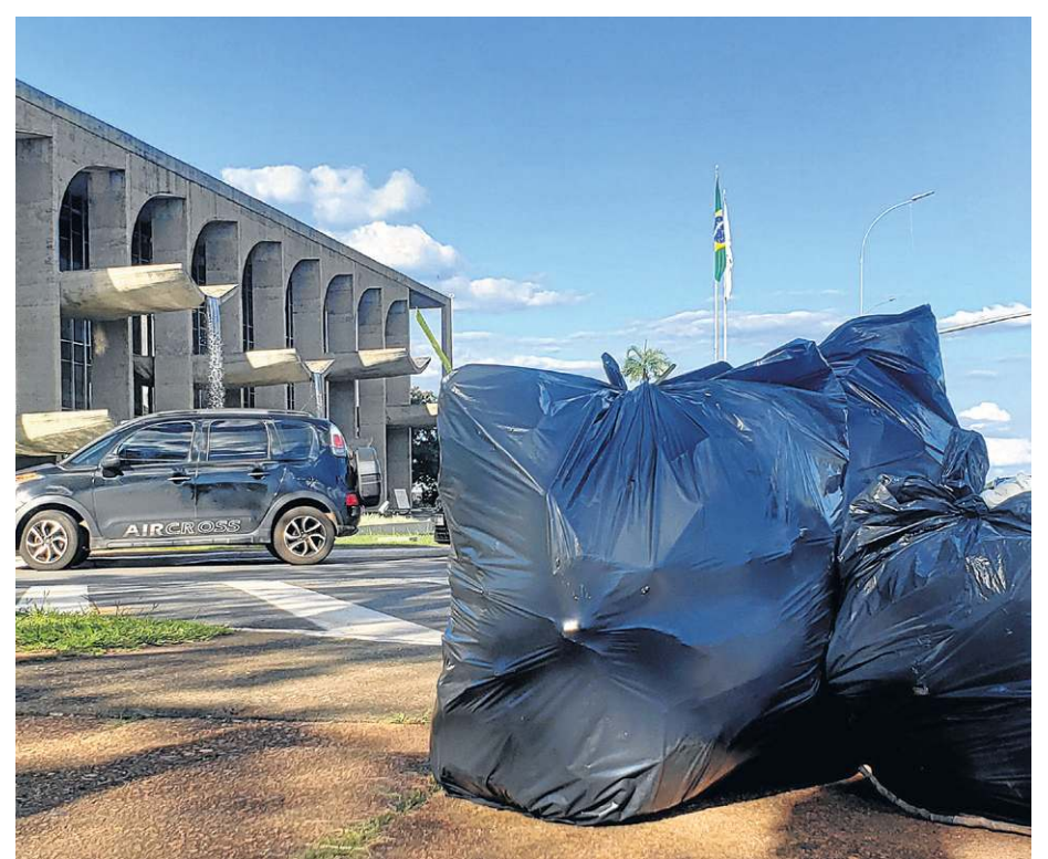
Equipes passaram a manhã de terça-feira limpando a sujeira na região
