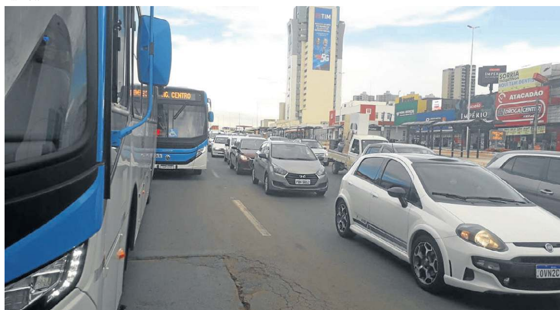
Obra do Túnel de Taguatinga dá um nó no trânsito no centro da cidade e dificulta a vida de pedestres
