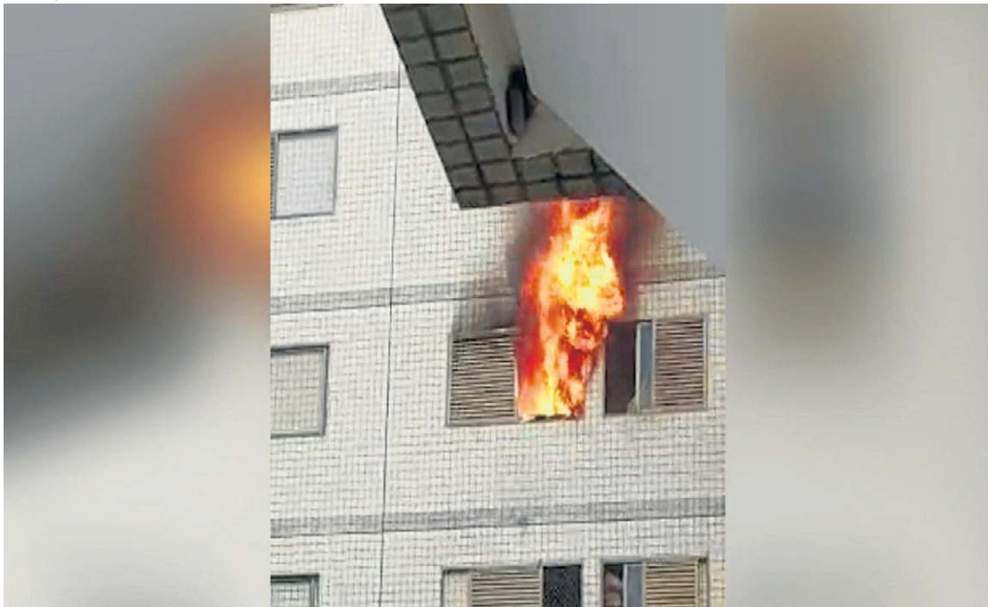
Calor pode ser sentido mesmo depois que vizinhos, alertados por alarme, saíram do prédio
