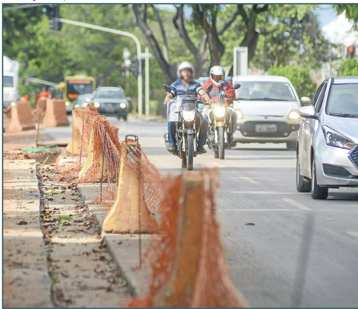
Obras devem dar uma nova cara para a avenida mais famosa do DF
