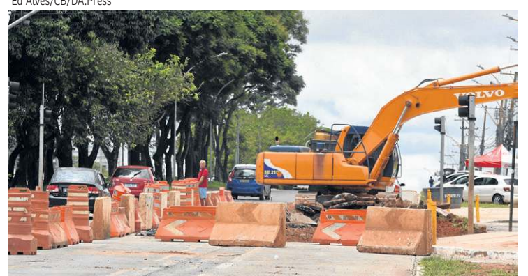
Obras de melhorias na Avenida Hélio Prates, no Centro da cidade
