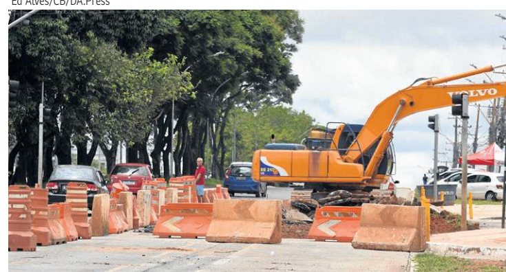
Obras de melhorias na Avenida Hélio Prates, no Centro da cidade
