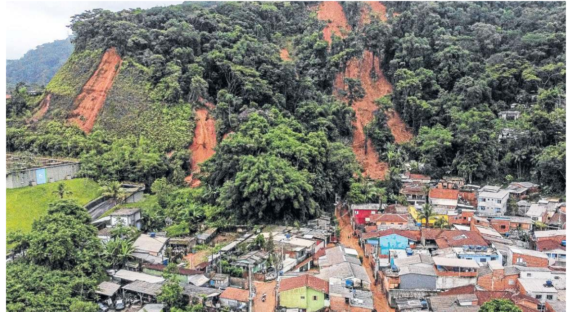
Entre Juquehy e a Praia Preta, em São Sebastião, terra cobre completamente o asfalto
