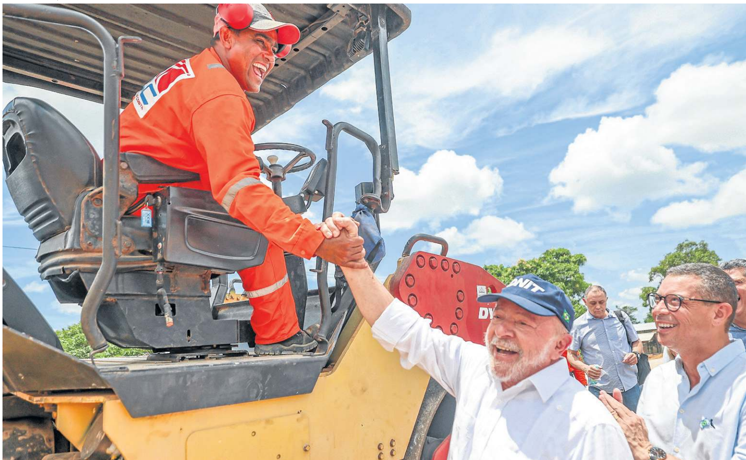
Lula cumprimenta um dos trabalhadores do canteiro de obras de duplicação da BR-101/SE: “O Brasil está voltando a funcionar”
