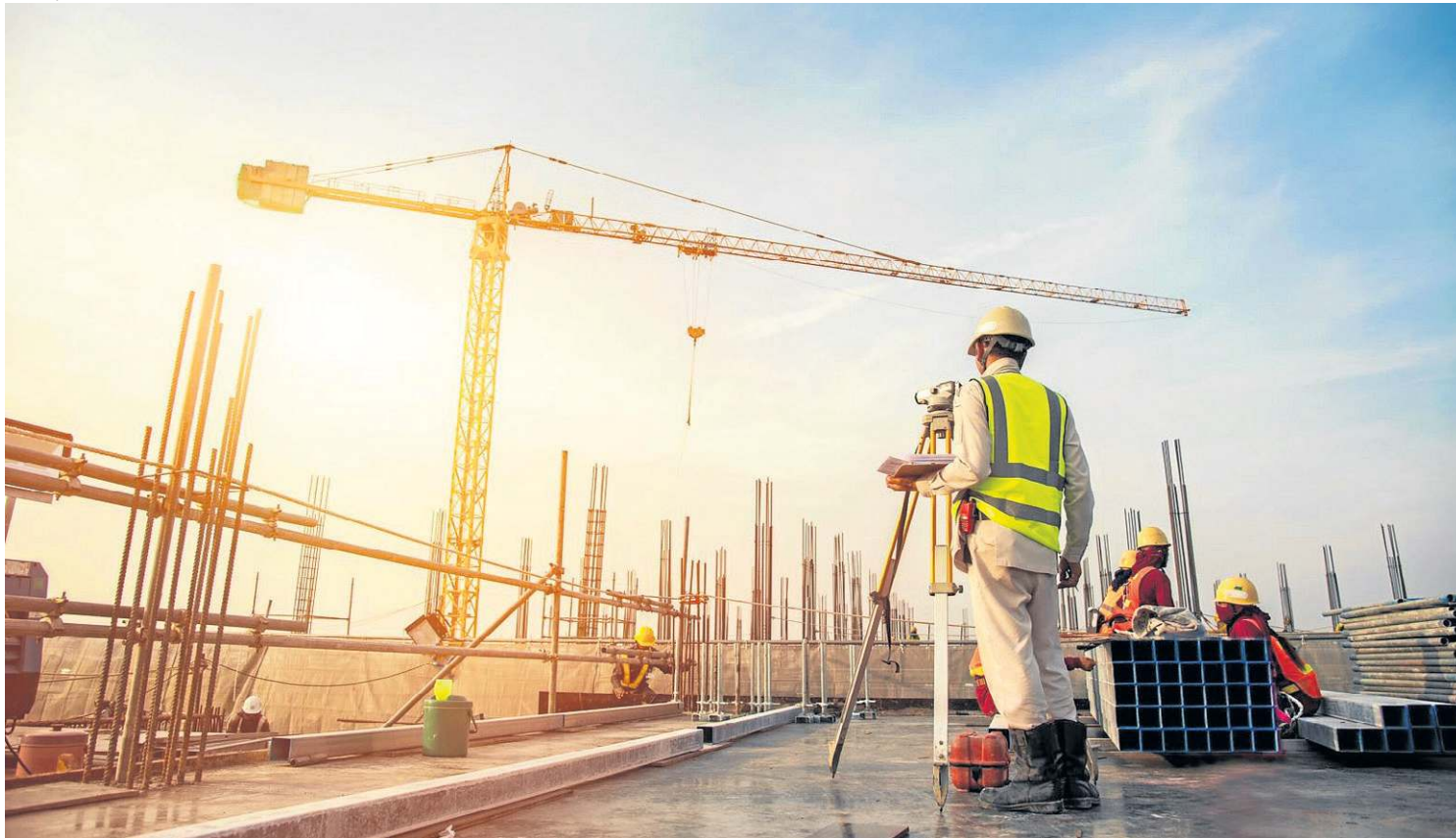
Setor da construção civil representa 55,9% do PIB da indústria local e, no ano passado, gerou mais de sete mil novos postos de trabalho
