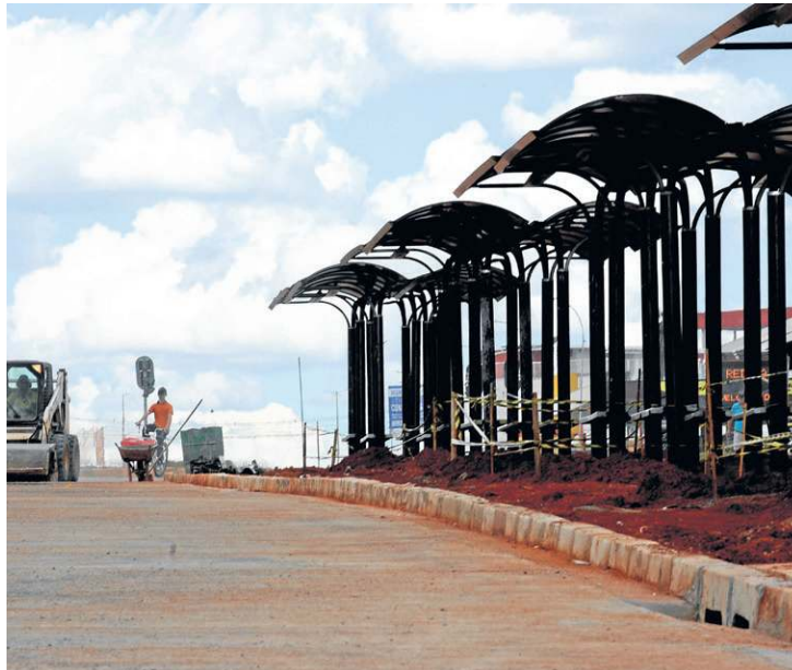
Falta de insumos no mercado atrasou os trabalhos em Taguatinga
