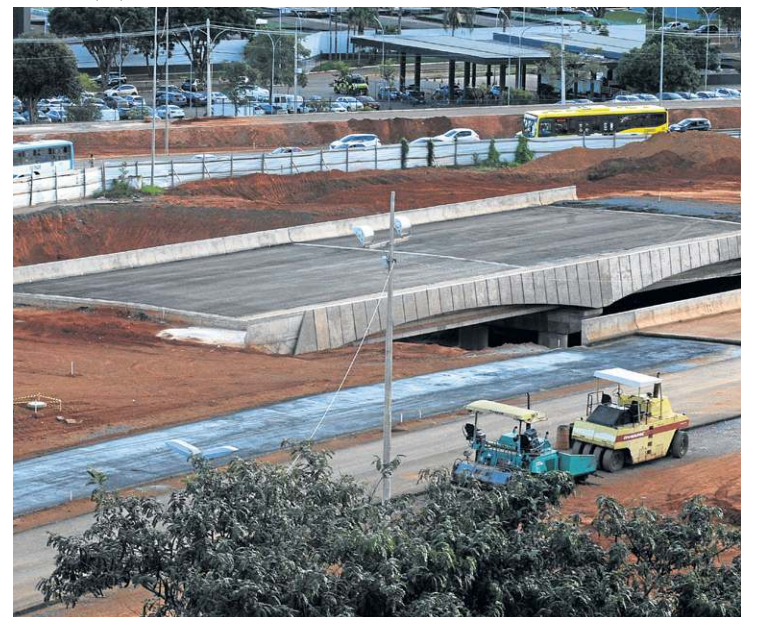
Viaduto do Sudoeste vai beneficiar 25 mil motoristas, diz o GDF
