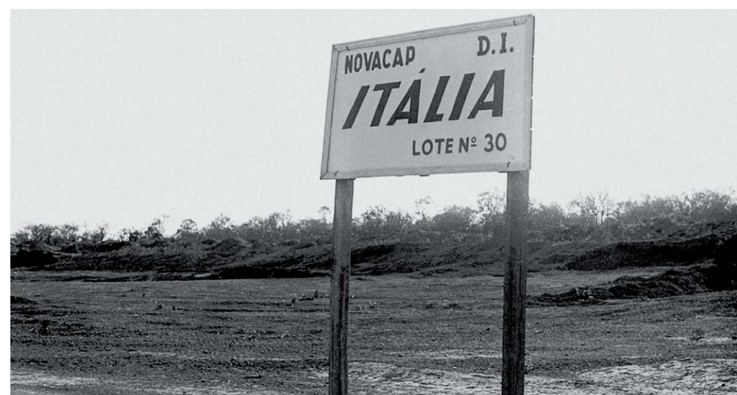
Placa indicando o terreno (lote nº30) onde futuramente seria erguida a Embaixada da Itália em Brasília, em 1958
