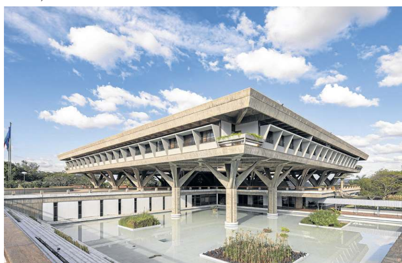
Sede da Embaixada da Itália em Brasília: prédio imponente desenhado por Pier Luigi Nervi
