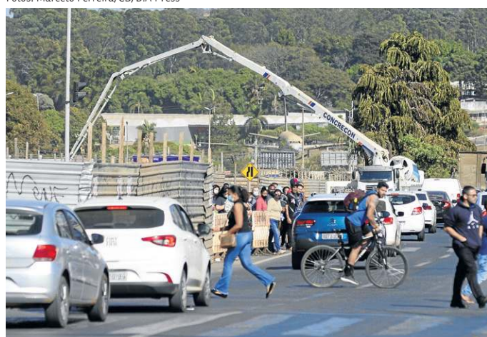
Iniciada em julho de 2020, a obra vai custar R$ 275 milhões
