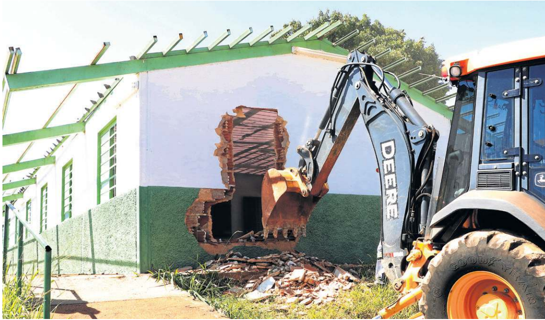
Demolição para reconstrução de unidades de ensino em Samambaia começa pela Escola Classe 425
