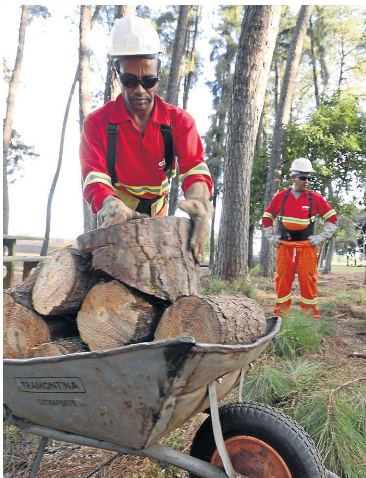
Os troncos são serrados para facilitar o transporte do entulho
