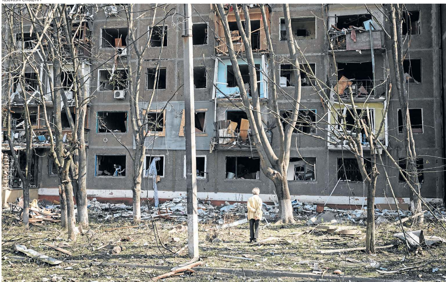
Idoso observa prédio residencial atingido por mísseis na cidade de Kramatorsk, no leste da Ucrânia: 71 dias de bombardeios
