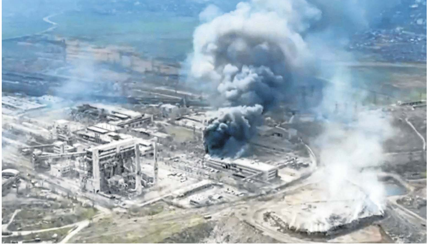
Complexo de Azovstal, em Mariupol, após bombardeios russos: planta é bunker do que sobrou das forças ucranianas na cidade
