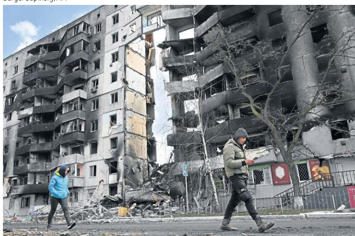
Prédio atingido por mísseis em Borodyanka, a noroeste de Kiev
