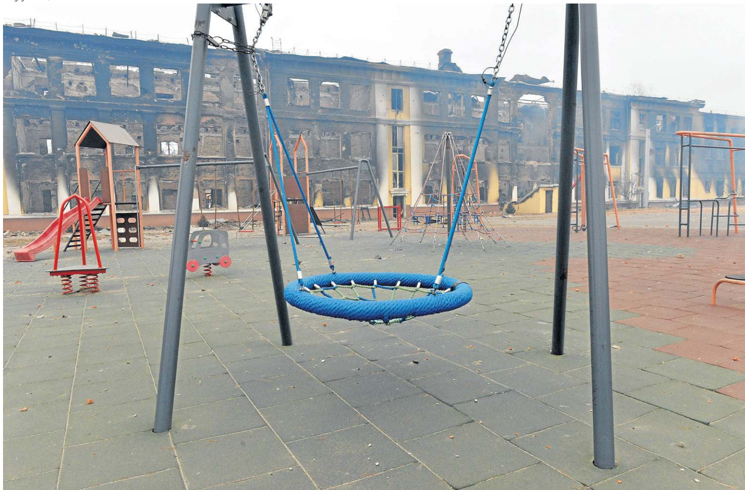
Escola destruída por bombardeio russo no centro de Kharkiv, a segunda maior cidade da Ucrânia, alvo de ataque maciço
