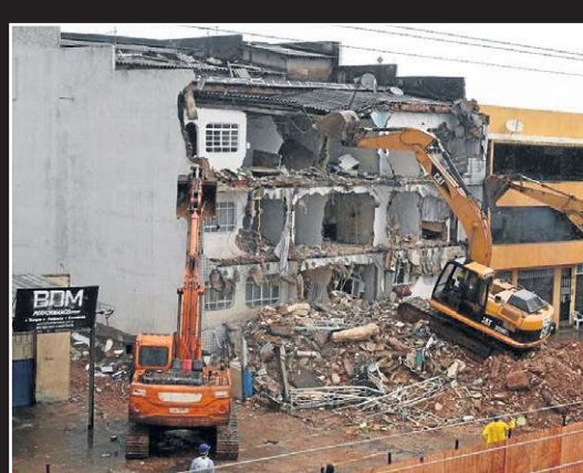
Previsão inicial da Defesa Civil era de que a demolição durasse dois dias
