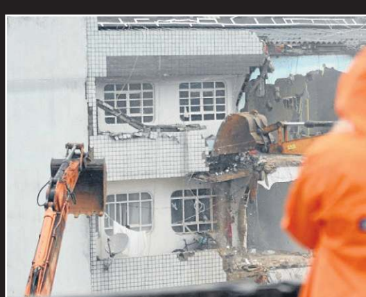
Trabalhos de demolição foram coordenados pela Defesa Civil
