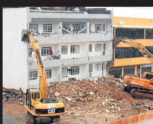
Demolição começou às 8h30 na QSE 20, de Taguatinga Sul
