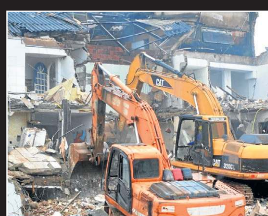
Porém, os trabalhos foram concluídos ainda na tarde de ontem
