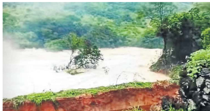
Prefeitura pede que moradores próximos de barragem deixem casas
