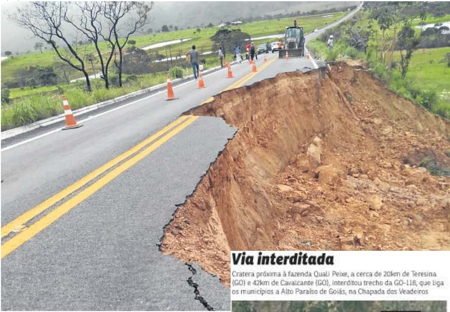
Cratera na GO-118 tem cerca de 30 metros de comprimento
