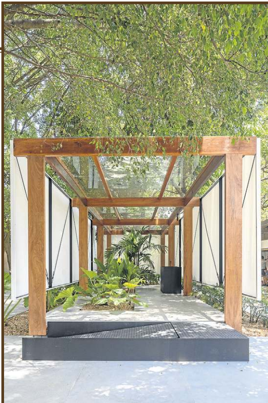
O Espaço Botânico usa uma tela solar para fechamento como artifício para livre ventilação e proteção dos raios de sol
