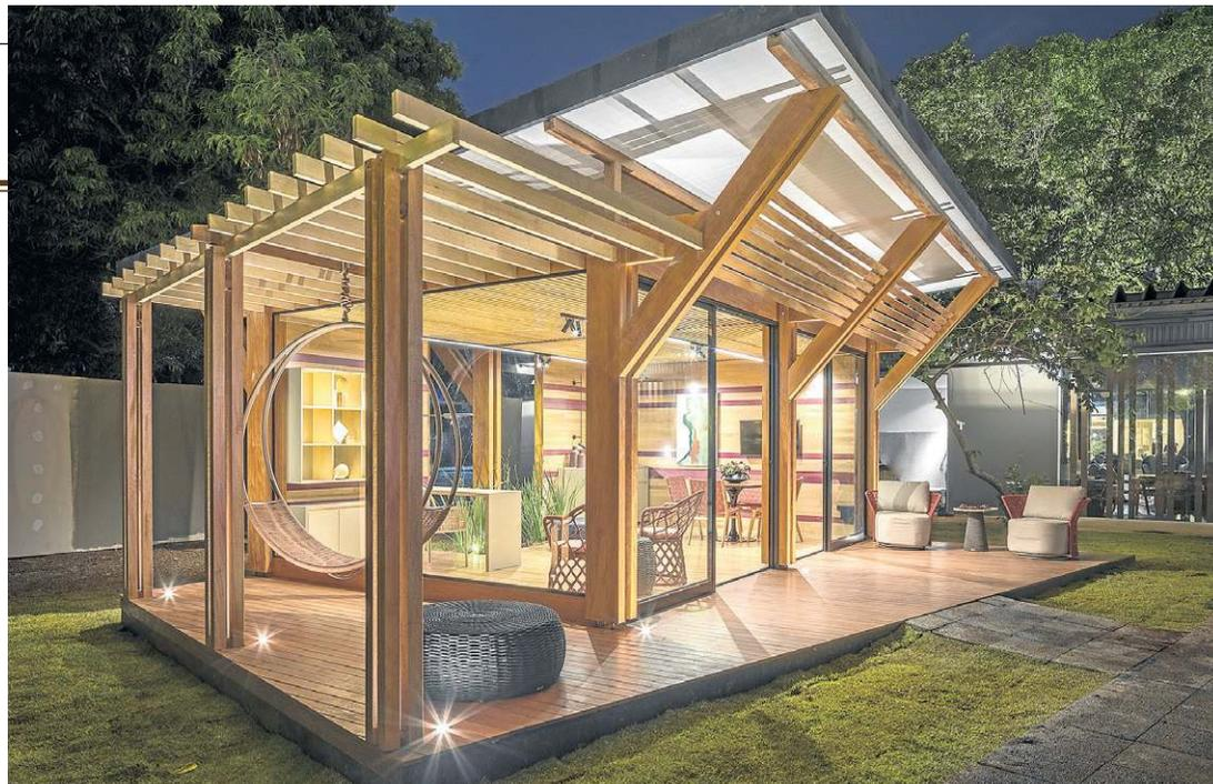
A construção pré-fabricada do espaço Wood Office possibilita sucessivas montagens, com mínima geração de resíduos, soluções construtivas e ventilação natural e cruzada
