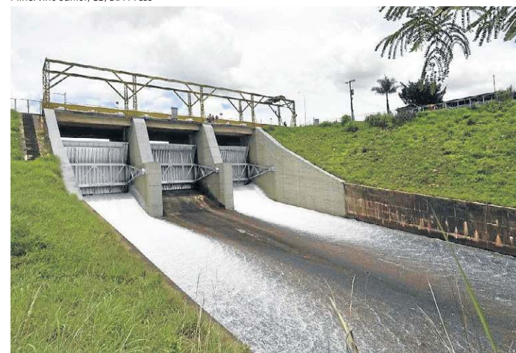
Com abertura de 5cm, 16 mil litros de água escoam por segundo
