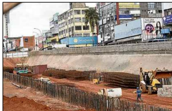
Estão em andamento a execução da rede de drenagem pluvial e a montagem das estruturas metálicas
