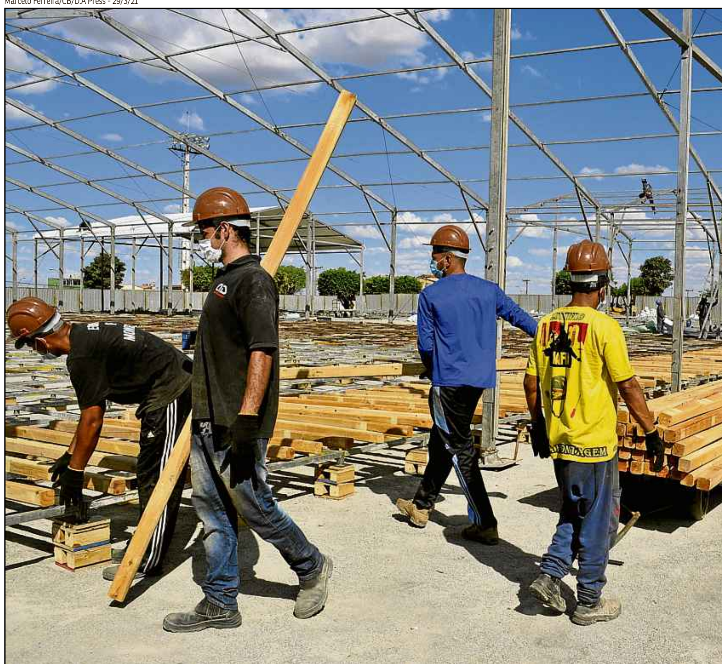
Entre junho de 2020 e maio de 2021, a construção civil foi responsável por gerar 12% dos empregos de carteira assinada no Brasil
