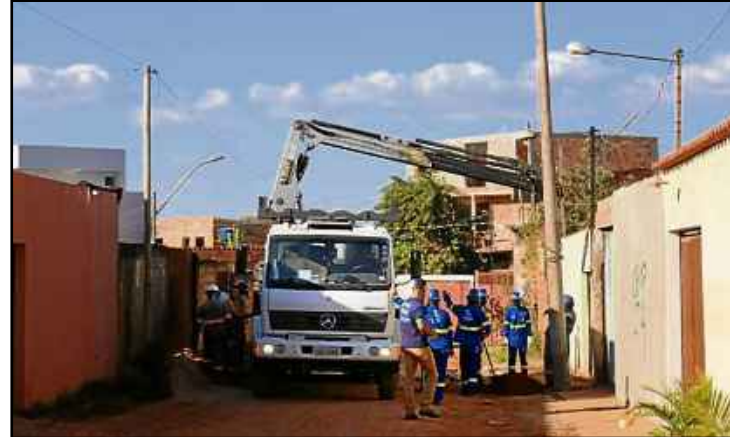
Neoenergia está instalando postes, transformadores e 12,5km de fiação
