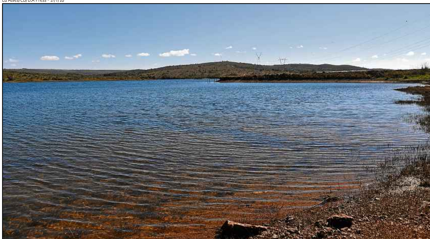
Obras para captação de água em Corumbá IV devem ser finalizadas no segundo semestre, segundo a Caesb
