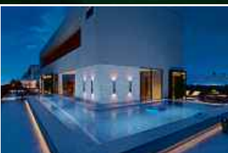
Perspectiva da piscina adulto - cobertura oeste
