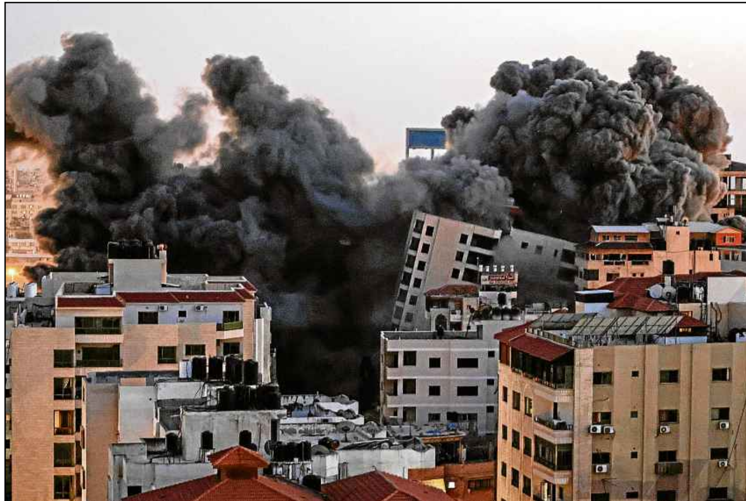
A Torre Hanadi, edifício de 12 andares, no centro da Faixa de Gaza, desaba após bombardeio de Israel: suposta base de escritórios de líderes do Hamas
