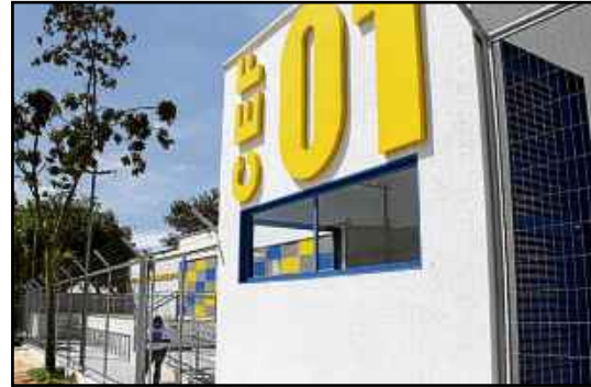
Centro de Ensino Fundamental 1, da Vila Planalto: reformas trazem conforto que ajuda no aprendizado
